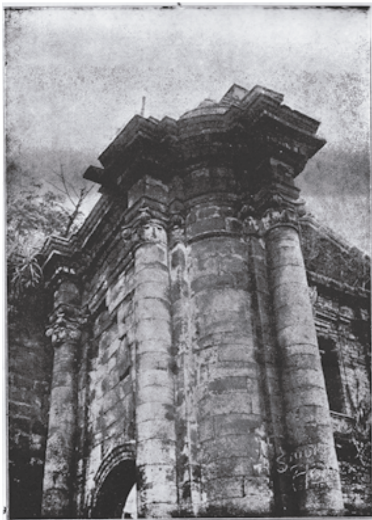
Outra amostra arquitetônica da igreja de S. Miguel, antes de começadas as obras de conservação.
