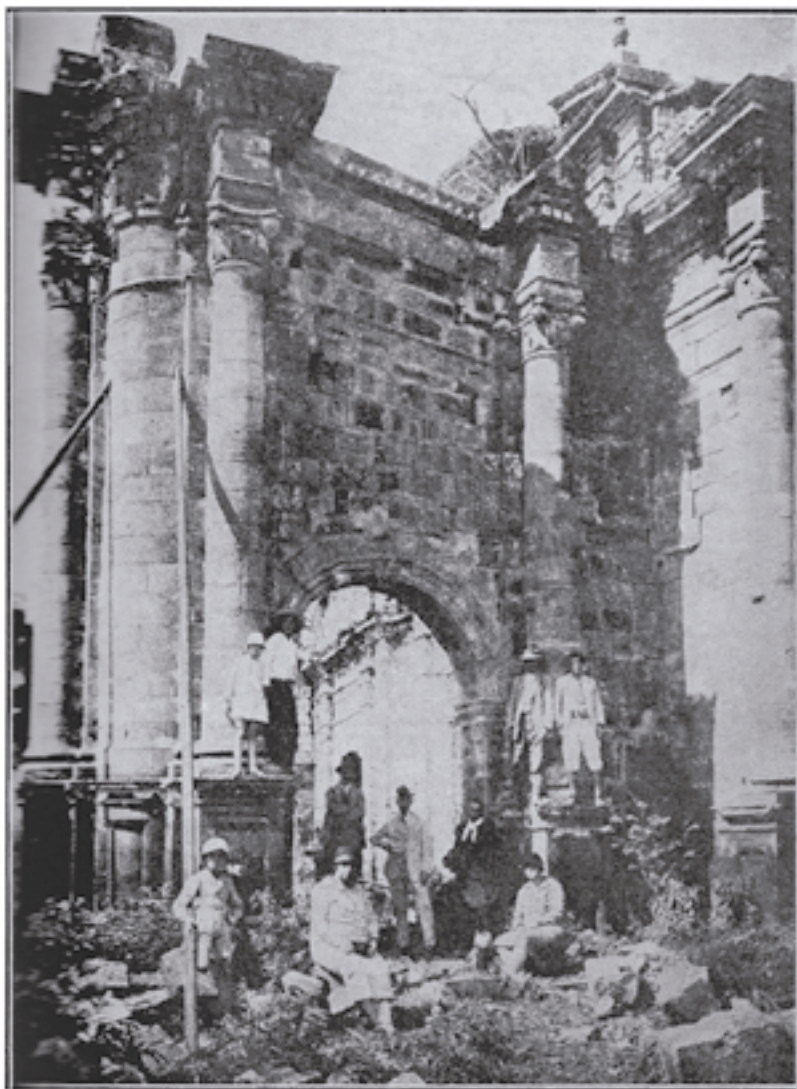
Paredão de admirável beleza arquitetônica, amparado por escoras, do templo de S. Miguel, antes do iniciadas as obras de conservação.
