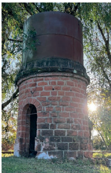
Caixa d'água edificada sob a tutela de Santo Brugalli, ao lado da estação férrea.
