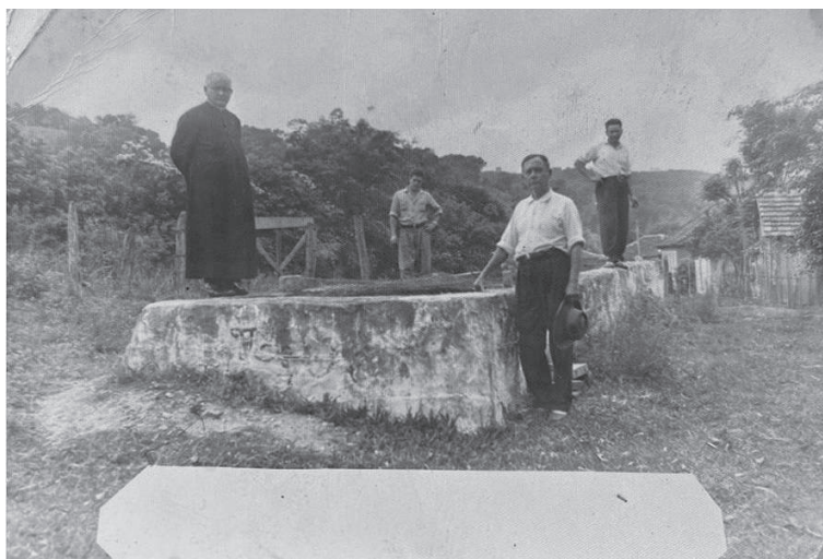
Tanques de captação de água dos morros do entorno de Mata, destinado a distribuição à cidade, em 1963. Aparecem na foto, em primeiro plano, a direita Santo Brugalli, e a esquerda o Monsenhor Pedro Wastowski, pároco de Mata por muitos anos.
